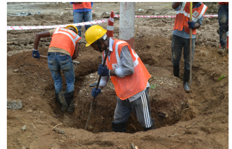
Root-ball excavation
