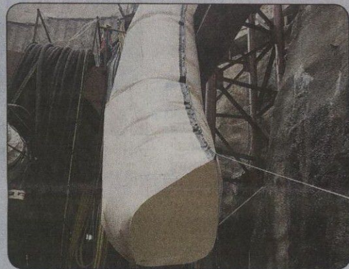
खुदाई का काम जमीन से 28 मीटर नीचे तक किया जा रहा है, इसलिए ऑक्सीजन की मात्रा में संतुलन बनाए रखने के लिए एयर ब्लोअर का उपयोग किया जाता है।
