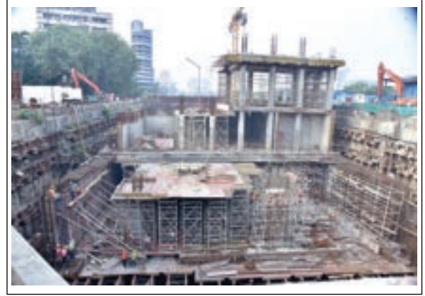
बीकेसी मेट्रो स्टेशनवर काम प्रगतीपथावर आहे
