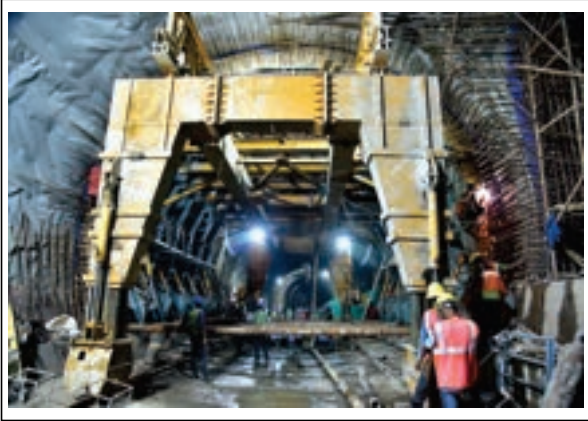
T2 मेट्रो स्टेशनवर NATM काम प्रगतीपथावर आहे
