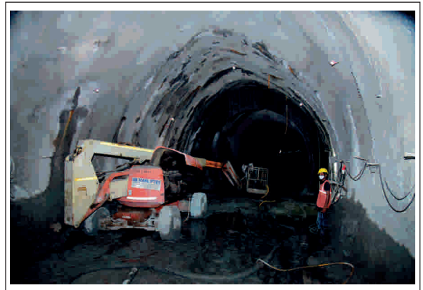
एनएटीएम समपार (क्रॉसओवर) आचार्य अत्रे चौक मेट्रो स्टेशन
