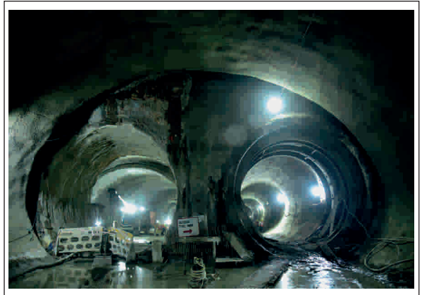
सहार रोड मेट्रो स्टेशन पर कैंची समपार (सीजर क्रॉसओवर) कार्य प्रगति पर
