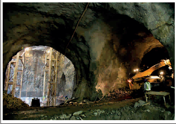
कालबादेवी मेट्रो स्टेशन पर एनएटीएम कार्य प्रगति पर
