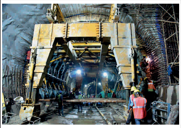
टी-2 मेट्रो स्टेशन पर एनएटीएम कार्य प्रगति पर
