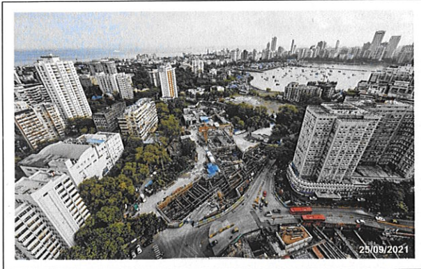
विधान भवन मेट्रो स्टेशन पर चल रहे कार्य का हवाई दृश्य
